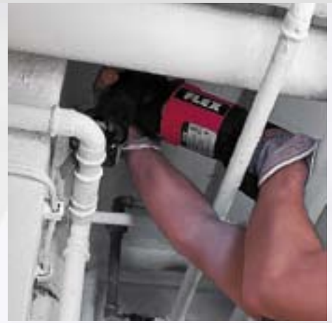
...pipes in remotest corner:
